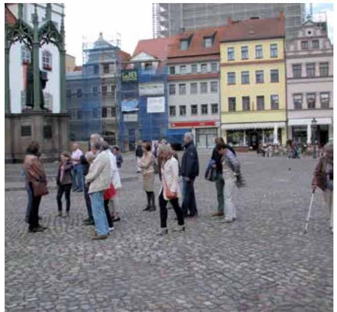
Gerüste und Baustellen wo man geht und steht, denn die Stadt putzt sich für das 500. Reformationsjubiläum, welches 2017 festlich begangen wird, heraus.
